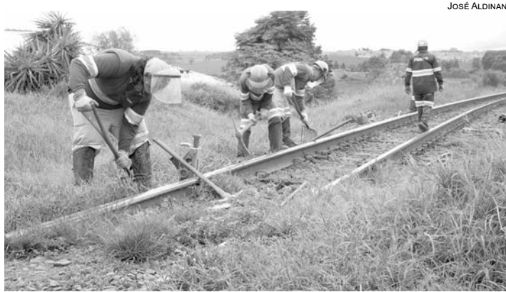
ALÉM da troca dos trilhos, a Prefeitura trabalhou com a recomposição do asfalto
